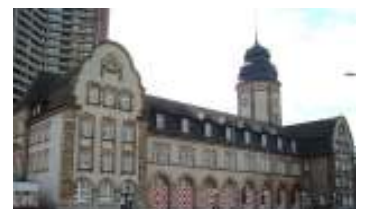
【地元テレビ局ライン・ネッカーコミュニティ放送 をしている旧消防署】
